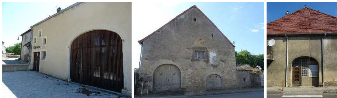
Aménagement contemporain réussi d'une voûte Courtefontaine // Façade au caractère patrimonial de qualité méritant un rafraîchissement Dampierre // Voute comblée peu qualitativement Dampierre
