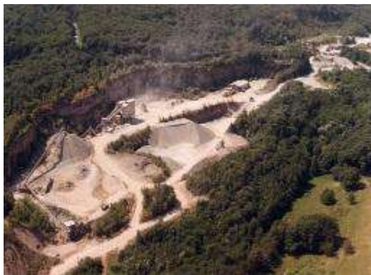
Vue de la carrière d'Offflanges, Société des carrières de Moissey
