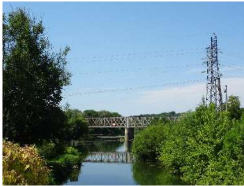
Ligne haute tension au dessus du Doubs, Salans
